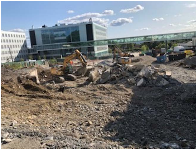
Bilde 4: Bildet viser påbegynt riving ved Radiumhospitalet, Oslo universitetssykehus HF
