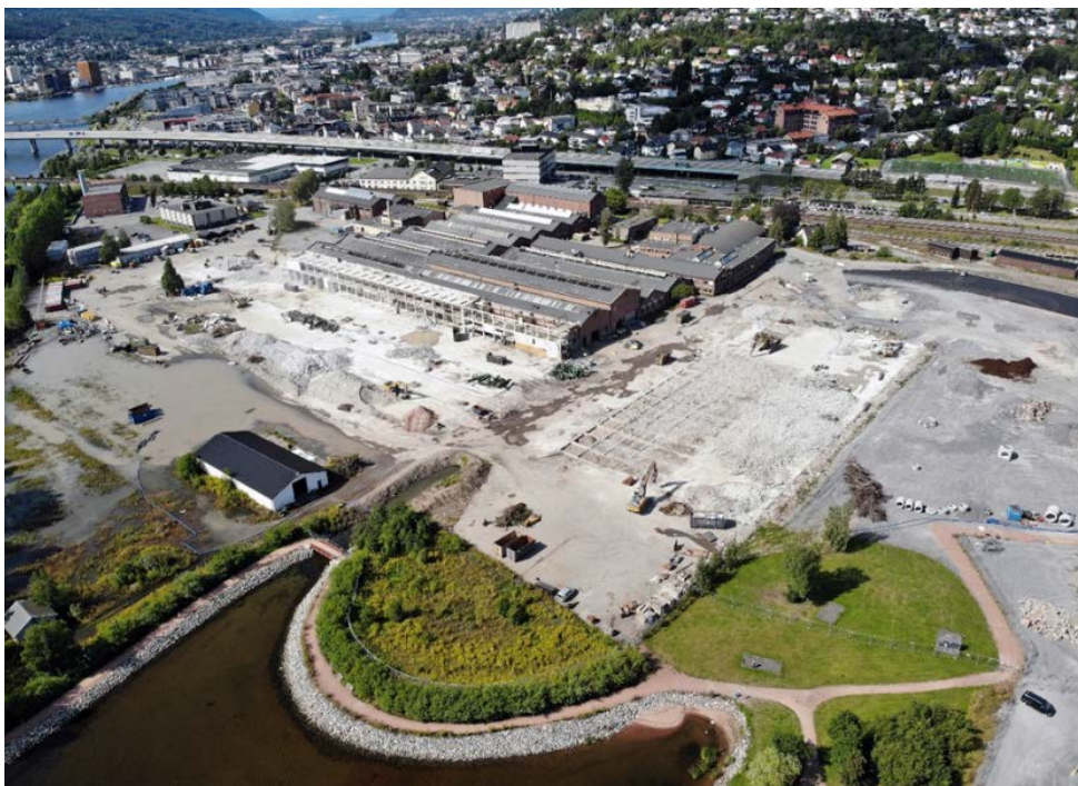
Bilde 1: Bildet viser påbegynt rivearbeider på Brakerøya, nytt sykehus i Drammen, Vestre Viken HF
