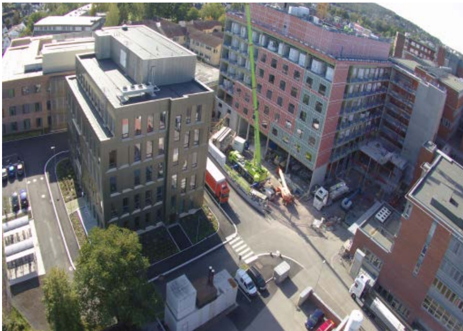
Bilde 2: Bildet viser nytt psykiatribygg og påbegynt nytt somatikkbygg, Sykehuset i Tønsberg HF
